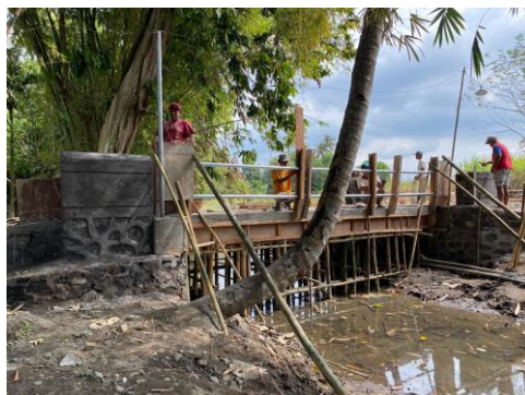
Pembangunan Jembatan Ngemplak
